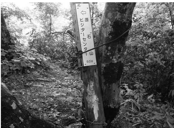
写真1 2021年5月の被害状況（箱屋谷山）
