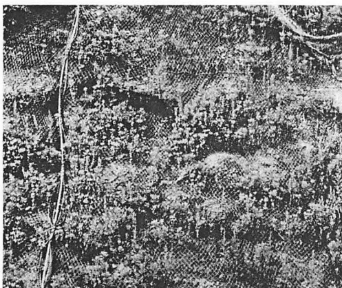
筋工と吹付（ヤマヨモギ, メドハギ）による緑化
