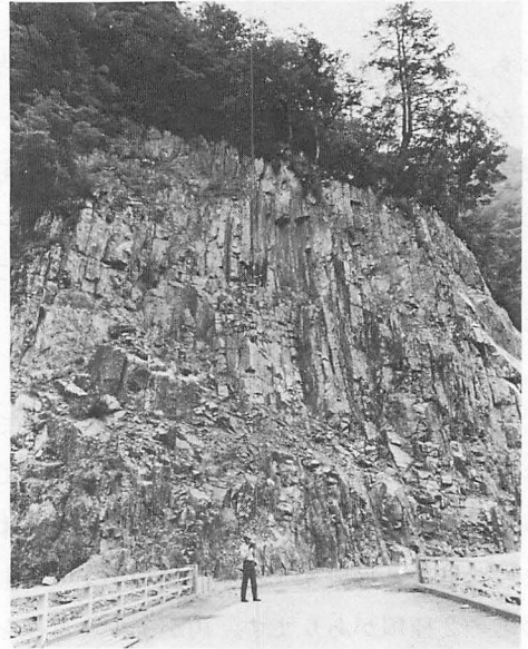
写真 2-2 溶結凝灰岩の柱状節理 (蛇谷橋付近)
