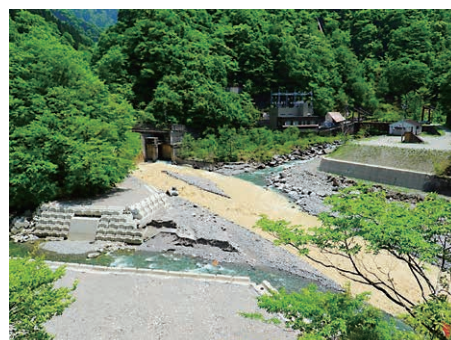
写真2 濁水発生状況（三ツ又発電所付近）
