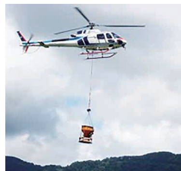
写真4 航空緑化導入工
