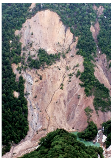
写真1 崩壊発生直後の状況
