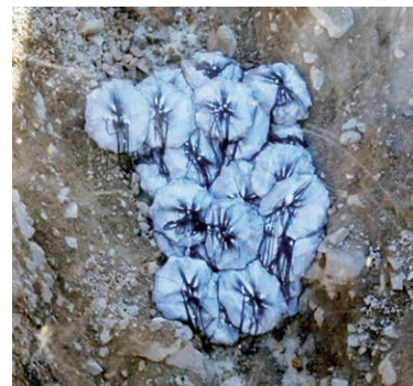
写真3 袋型石詰筋工
