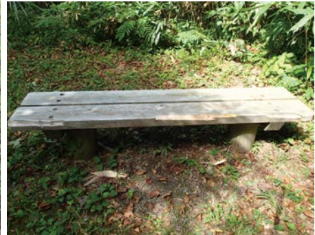
無垢材繰返し被害状況 (R3 8 月 西尾平付近)
