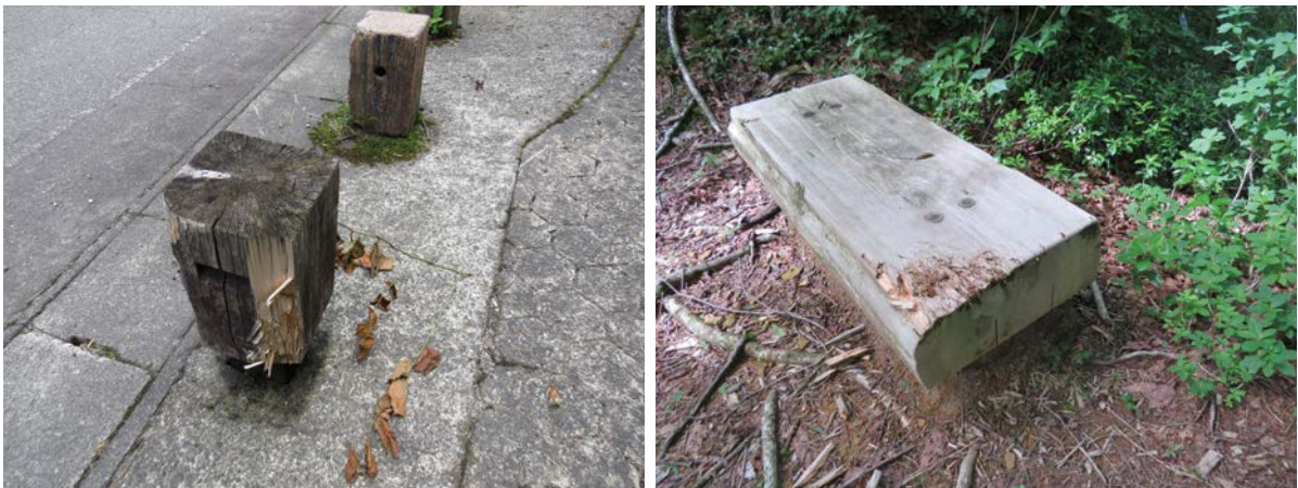
繰返し被害状況（R3 7月左： ねくらだに 根倉谷園地 右：岩屋俣谷園地）設置年不明
