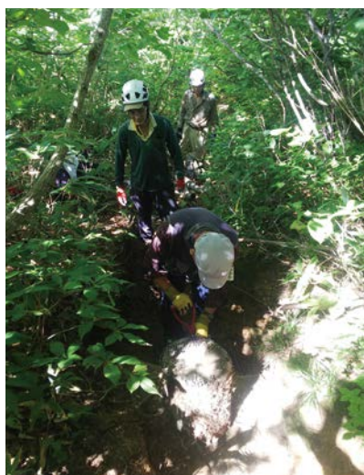
現地材を活用した登山道侵食箇所の補修作業（写真提供：白山の自然を考える会）
