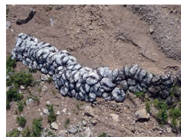
写真 11 袋型石詰筋工設置状況
