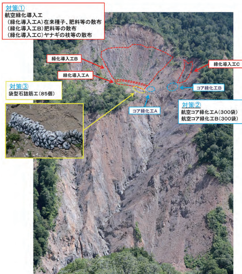
図 2 平成 30 年度対策工事実施状況
