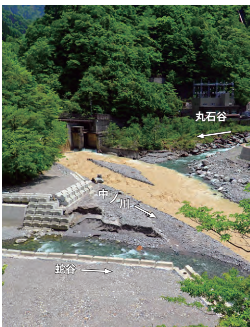
写真 2 濁水発生状況
