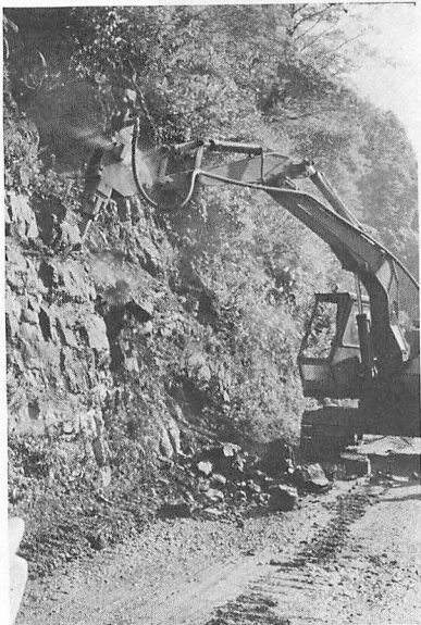
土木機械を使っての岩壁の切りくずし。
