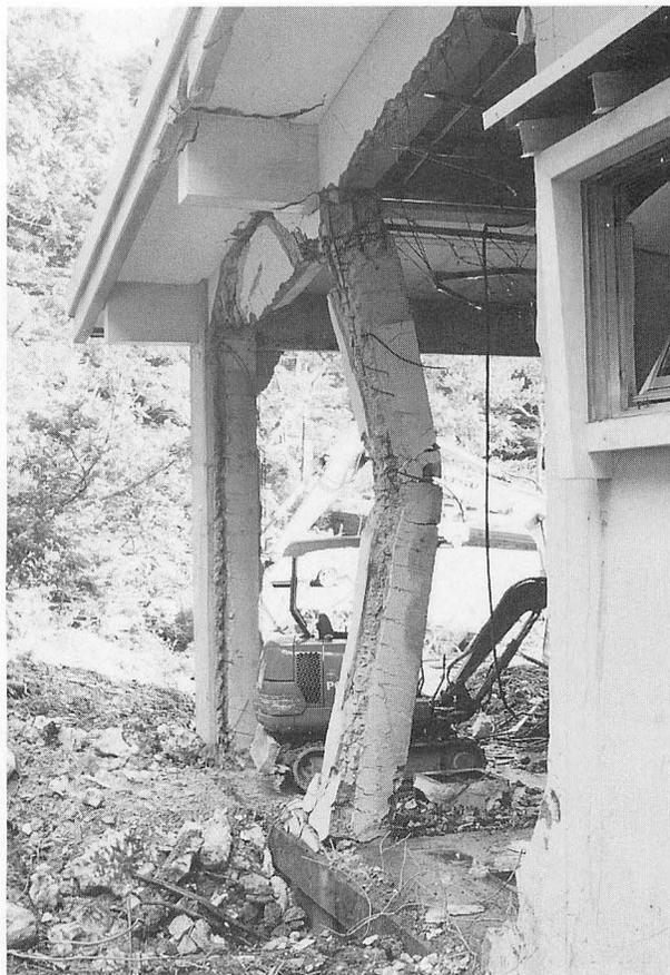
写真2 雪崩により完全に折れた柱
