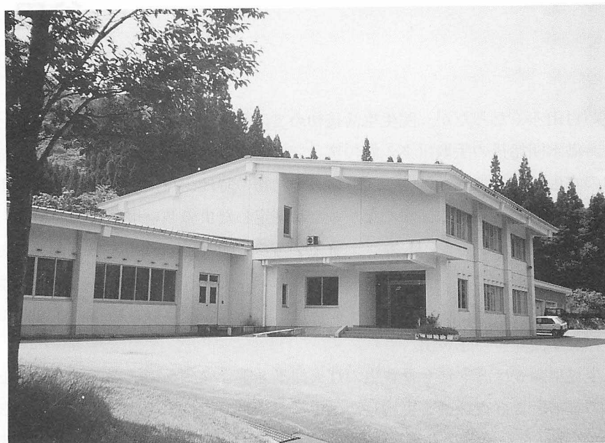
白山自然保護センター本庁舎
