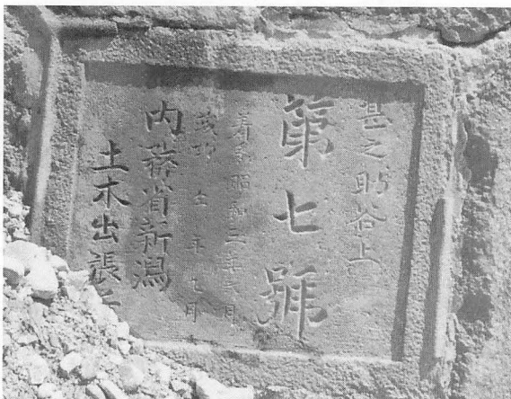
写真2 国直轄1号にあたる甚之助谷第7号ダム
