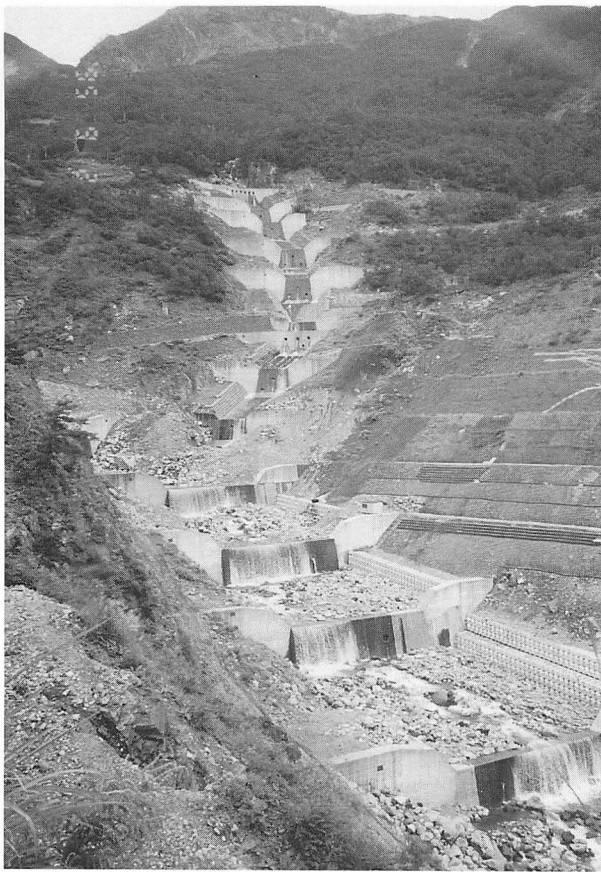
写真5 湯の谷治山ダム群 階段状にダムを施工することによって山腹からの崩壊を防ぎ、流出する土砂のスピードを緩めたりする。
