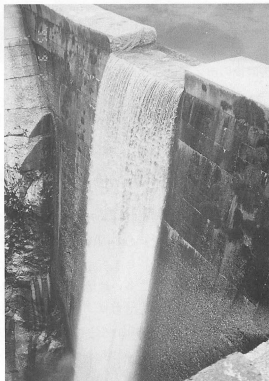
写真3 御鍋砂防ダム
