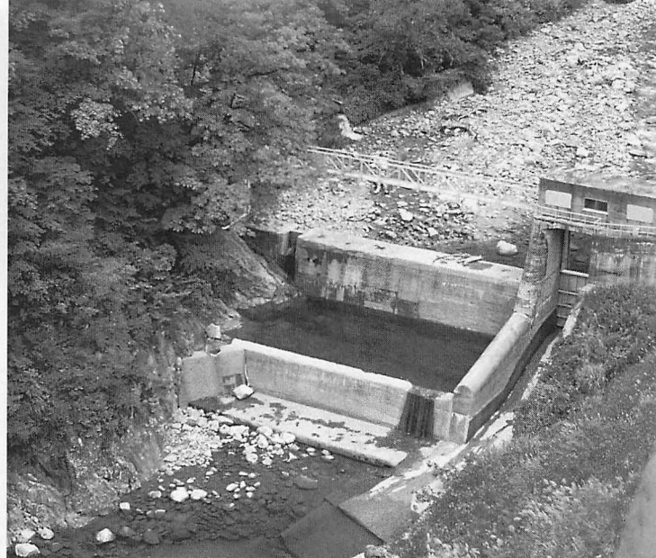
北陸電力蛇谷取水堰堤。漁道のない堰堤はイワナの移動がさまたげられます。
