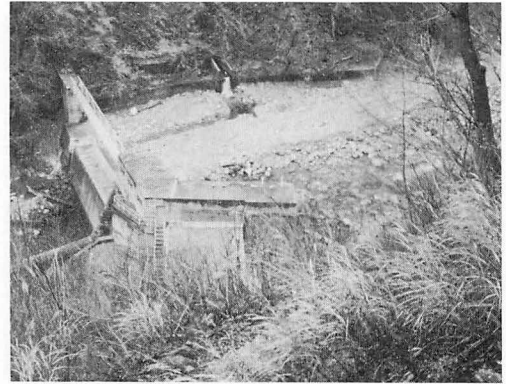
蛇谷の発電用取水堰堤 この堰堤より下流は川が干上るところもある。
