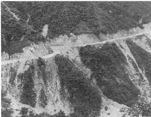
林道工事で流入する土砂
