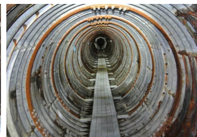
写真6 排水トンネル
