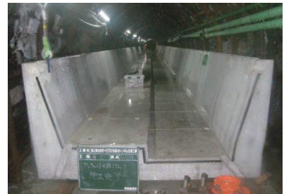
排水トンネル内の水路工
