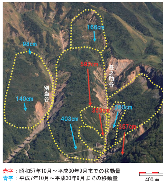
写真2 地すべりブロックと移動量
