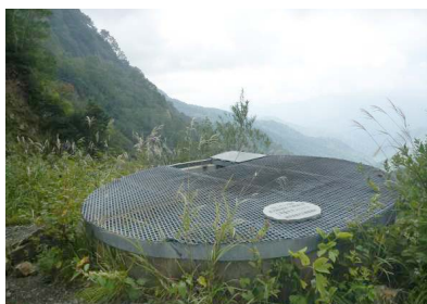
写真4 集水井の外観
