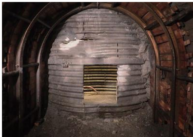
平成 28 年 9 月貫通した 排水トンネル
