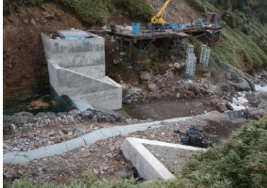
取水堰堤（令和元年完成予定）
