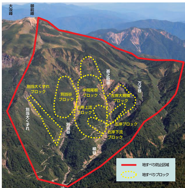
写真1 地すべり防止区域と地すべりブロック
