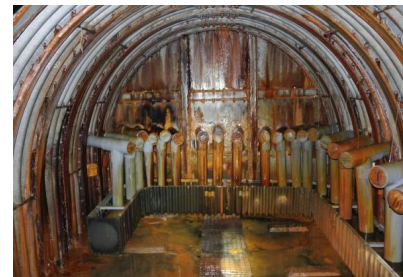
写真3 集水ボーリング
