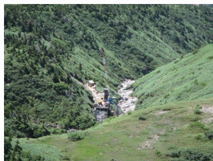
写真9 南竜水平道から見る工事現場
