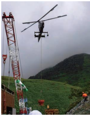
ヘリコプターによる コンクリート運搬
