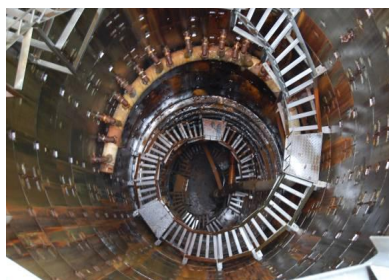
写真5 集水井の内部
