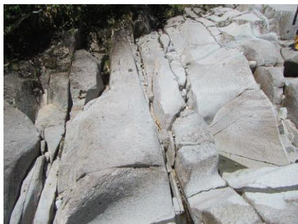
写真7 万才谷の河床の亀裂
