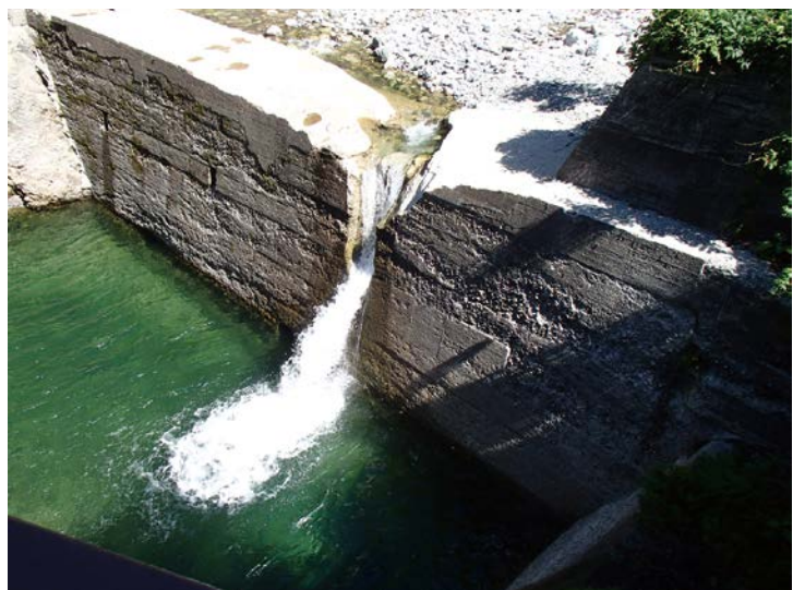
写真6 蛇谷に設置された堰堤
