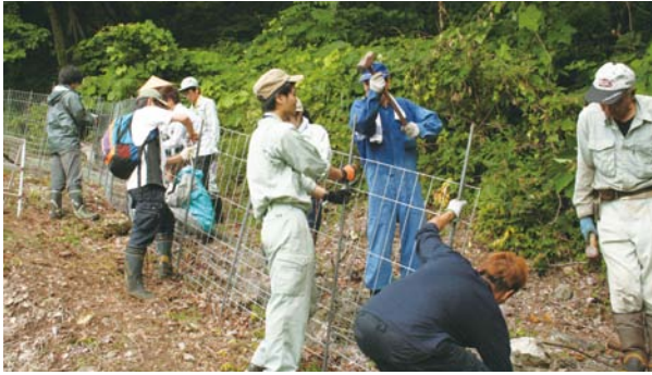
白山麓里山・奥山ワーキング「サクッとイノシシ防止隊」 近年農作物の被害が増大しているイノシシに対して、 侵入防止のための柵を設置しました。
