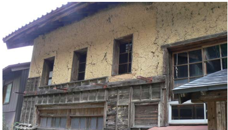
図3 土壁と縦長窓
