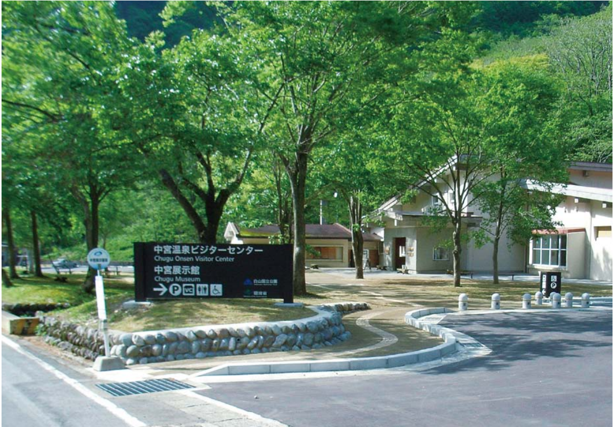
中宮展示館前の園地の全景。道路からもわかりやすい看板が設置されました。
