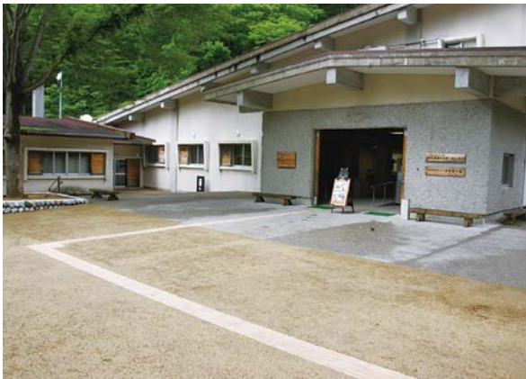
展示館の正面入口が、階段のないバリアフリー構造になりました。
