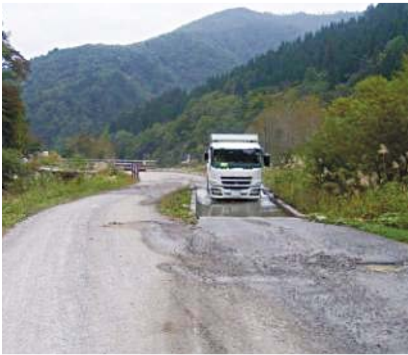
写真6 車両タイヤ洗浄プールを通過する工事車両
