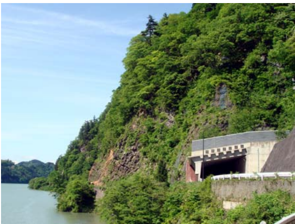
写真6 化石壁とライントネル
