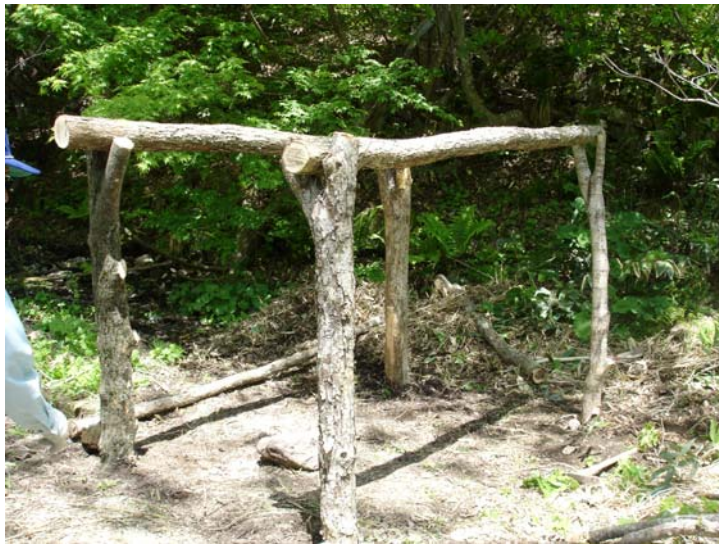
先がY字の柱と桁
