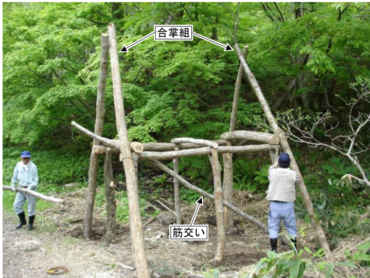
6本の柱に桁・梁を縛り合掌組で組む
