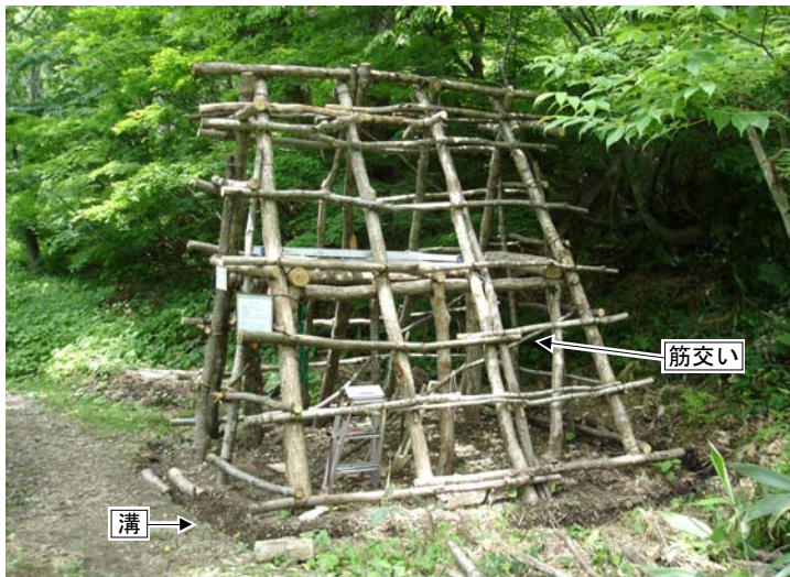
骨組みの完成
