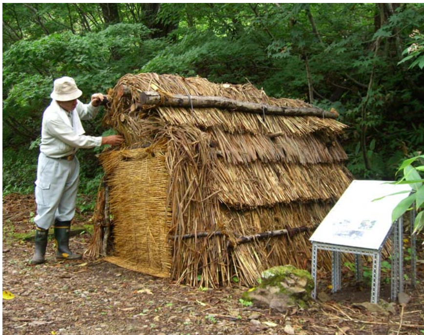
自然観察路沿いに完成した出作り小屋
