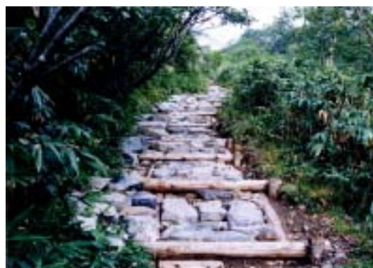
石張り工（砂防新道）
