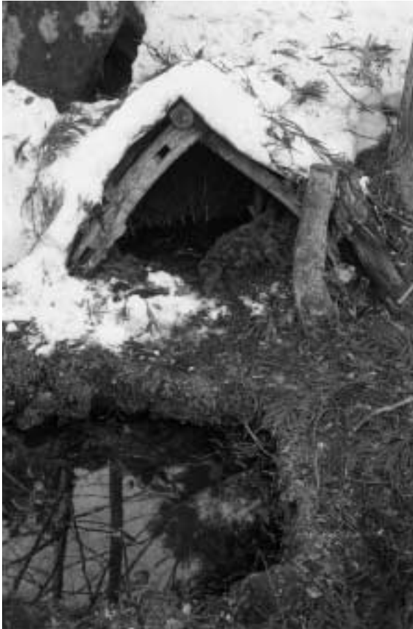
東荒谷の花小屋 小田孝太家、昭和54年 小屋の背面より湧き出る清水を利用する。冬でも清水は凍結しない。
