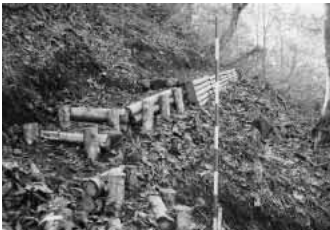
丸太積土止工
