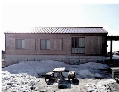
室堂公衆トイレ
