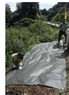
写真24 防草シートを敷設する様子
