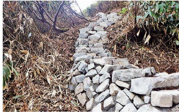
写真5 写真4の場所に練石積工・練石張工を施工
