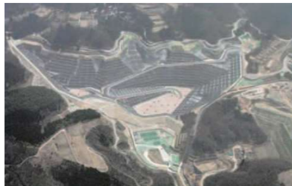
一般廃棄物最終処分場
