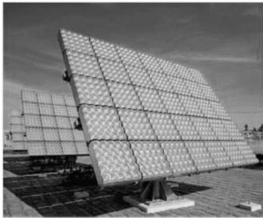
図 集光型太陽光発電システム例
