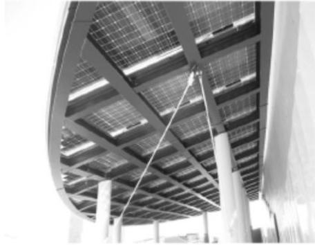
図 建物一体型太陽光発電システム例
