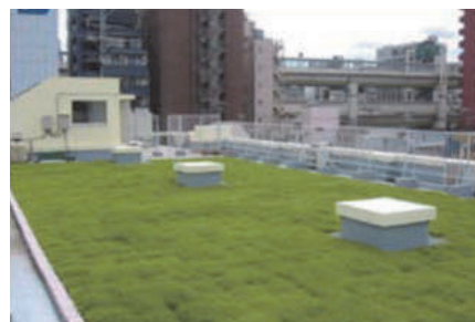
屋上緑化の基盤
