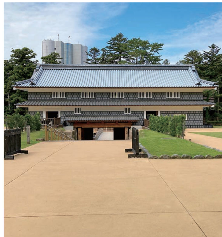
施工例：金沢城址公園 (鼠多門)
