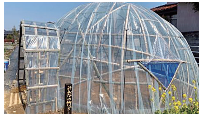
竹ドーム (小:直径3.0m、高さ2.0m) 竹ドーム (大:直径5.5m、高さ2.8m)
