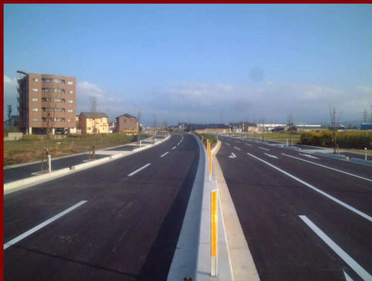
観音堂上辰巳線舗装工事 平成18年度施工 発注者：金沢市 道路建設課
