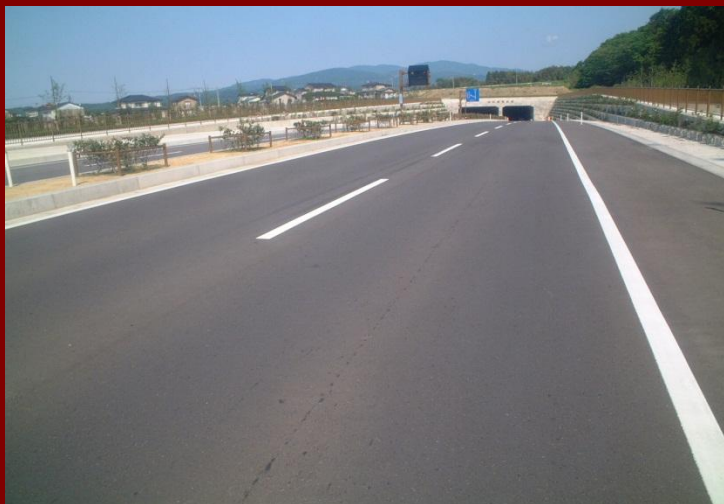
山側環状（野田地内）平成17年度施工 発注者：石川県県央土木総合事務所
