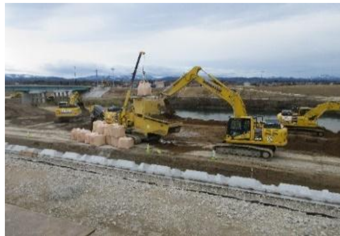
自走式土質改良機による土質改良工事
