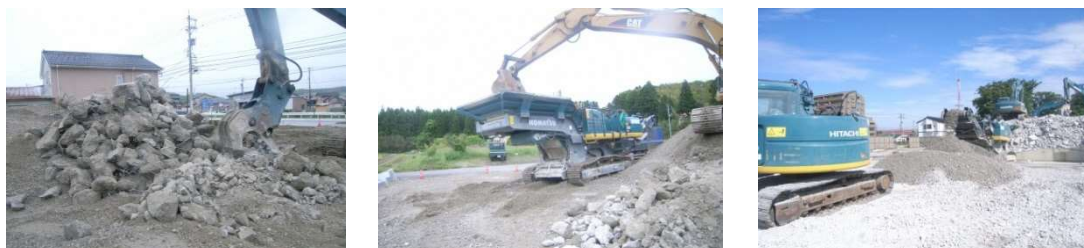
コンクリート塊は現場で破砕、粒度調整して建築資材化
