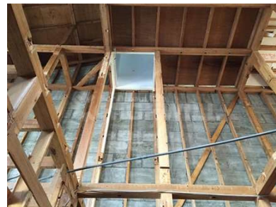
リフォーム工事現場
