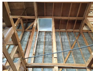
リフォーム工事現場
