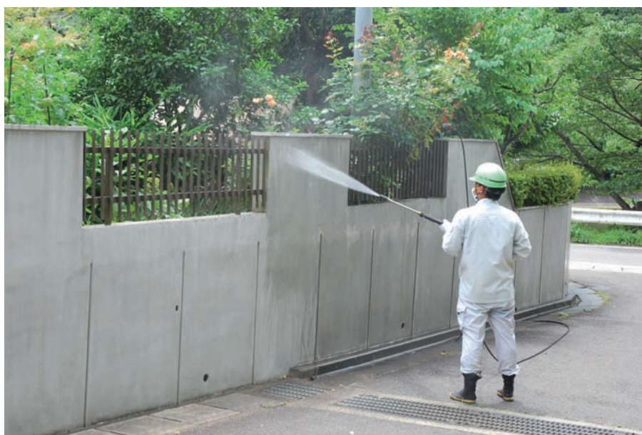
図-2-11：外塀の除染の例（高圧洗浄）
