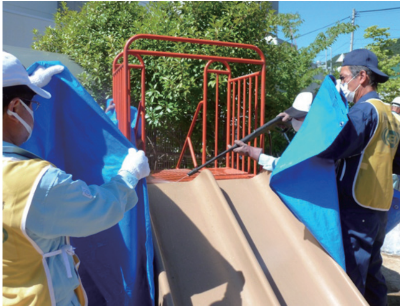
図-2-13：遊具の除染の例（高圧洗浄）
