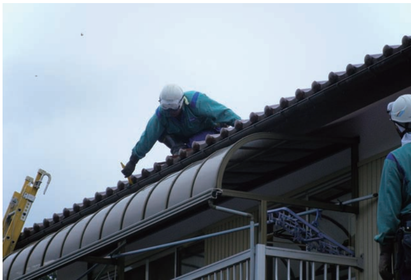
図-2-9：側溝の高圧水除染の例
