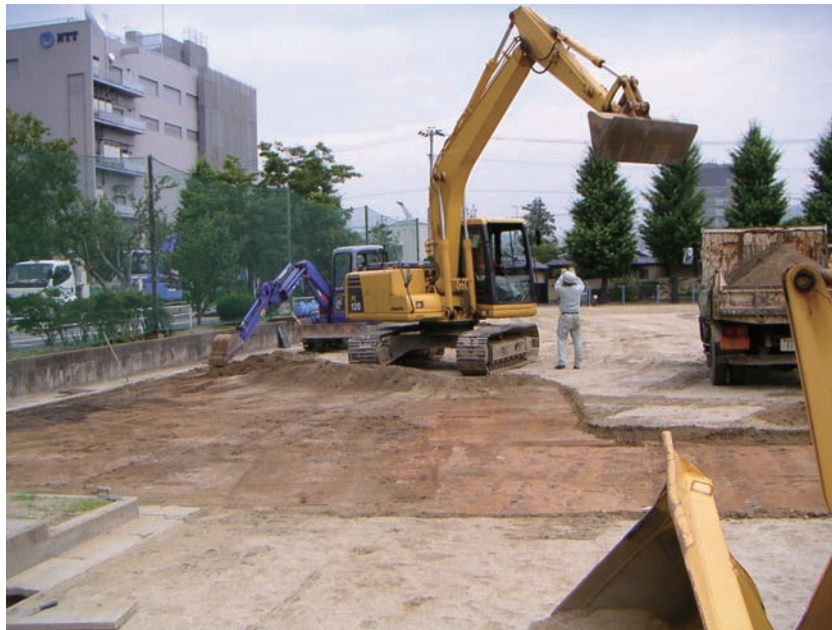
図-2-25：校庭の除染の例（表土の削り取り）
