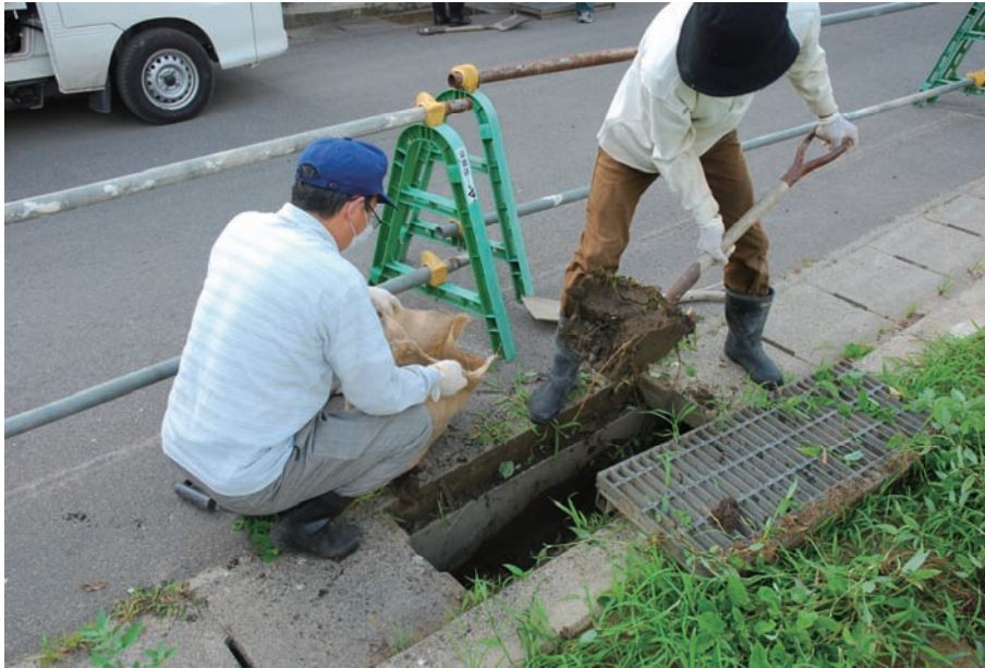
図-2-17：側溝の除染の例（汚泥の除去）
