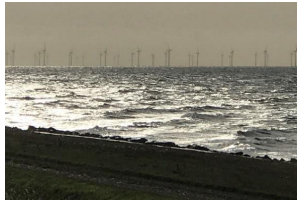
ロラン島からドイツ沿岸を望む。162基の洋上風力発電群があり、300メガワットの能力がある。漁礁を作ることで魚が増え、漁業に携わる人も喜ぶ。常時一定方向から偏西風が吹くデンマークとは違い、日本には風力発電に適した地方が少なく、潮力発電に適しているのではとのこと。
