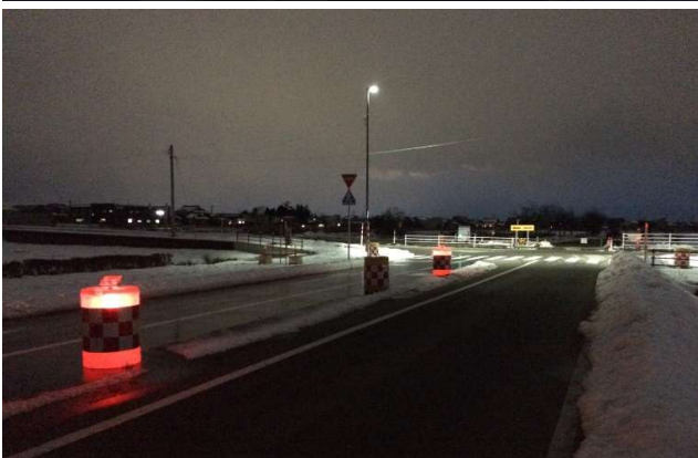
道路照明が少ない、暫定共用部での仮設分離帯に設置
