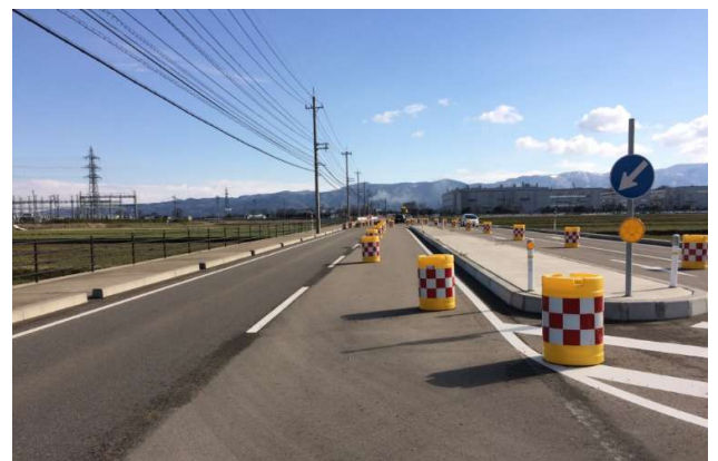
道路照明が少ない、暫定共用部での仮設分離帯に設置
