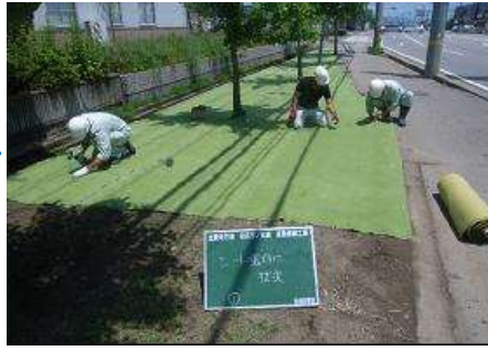
②シート敷設
