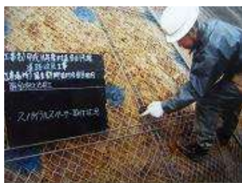
法枠組立 (台座設置状況)
