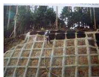
枠内吹き付け
