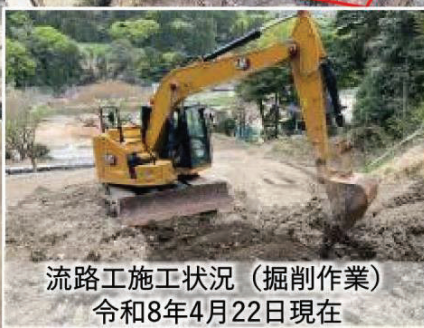
流路工施工状況(掘削作業) 令和8年4月22日現在
