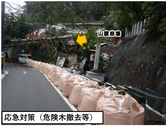
【被災状況】 輪島市鳳至の山腹崩壊
