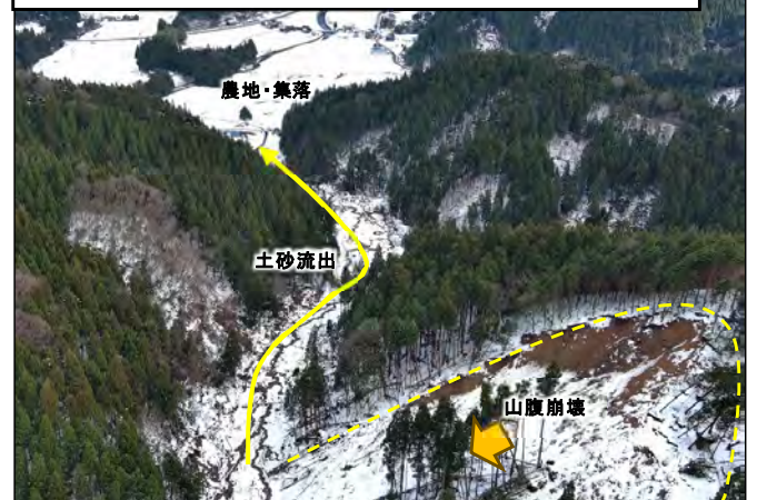
【被災状況】 輪島市興徳寺の山腹崩壊と土砂流出
