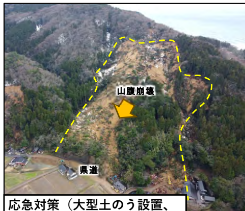
【被災状況】 珠洲市大谷の山腹崩壊
