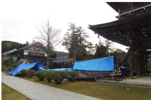
<總持寺祖院(輪島市)の被害>
