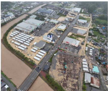
<輪島市の応急仮設住宅の床上浸水>
