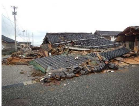
<旧角海家住宅(輪島市)の被害>
