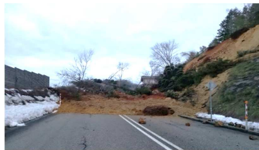
<道路寸断(珠洲道路)>
