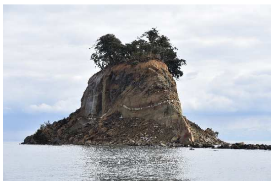
<見附島(珠洲市) 崩落>
