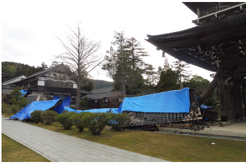
< 總持寺祖院(輪島市)の被害 >
