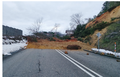
<道路寸断(珠洲道路)>
