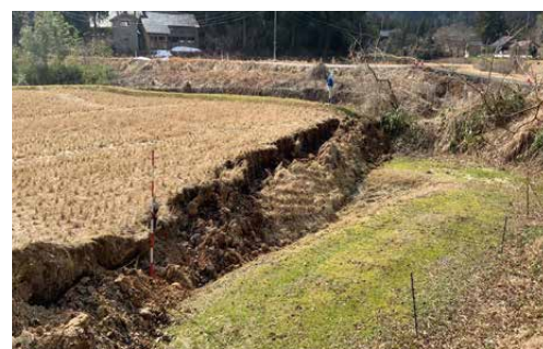
<農地の地割れ(珠洲市若山町中)>
