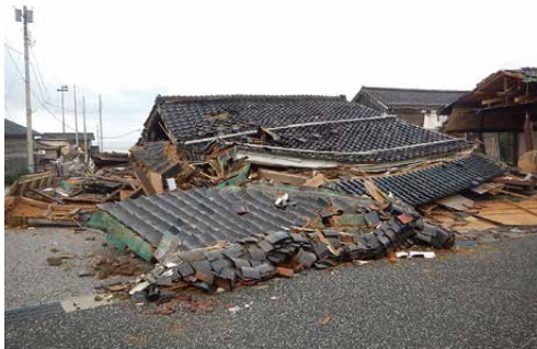
＜旧角海家住宅(輪島市)の被害＞
