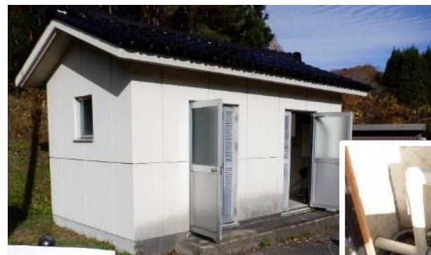
小規模水道施設 (ポンプ場)
