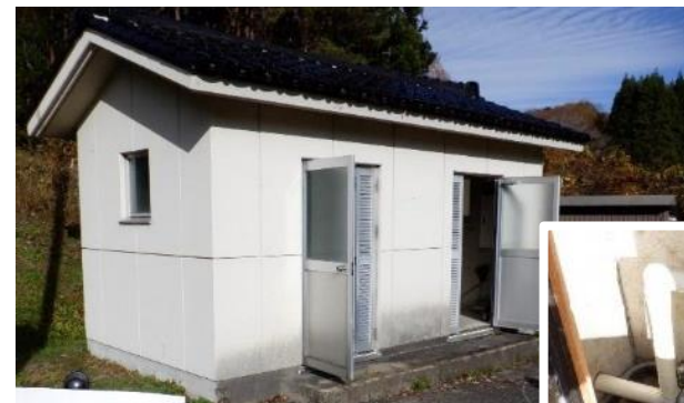
小規模水道施設 (ポンプ場)
