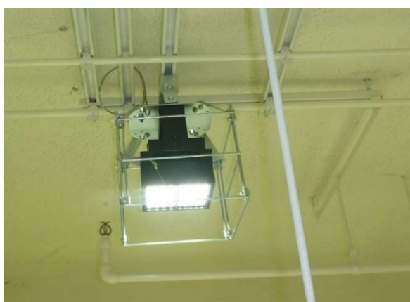
照明器具（落下防止ワイヤー設置）
