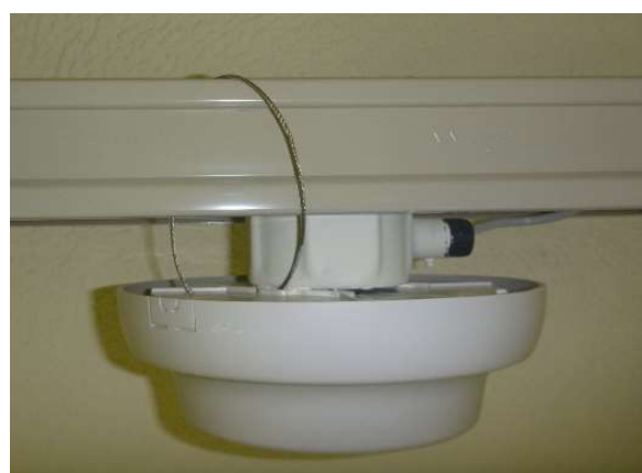
照明器具（落下防止ワイヤー設置）
