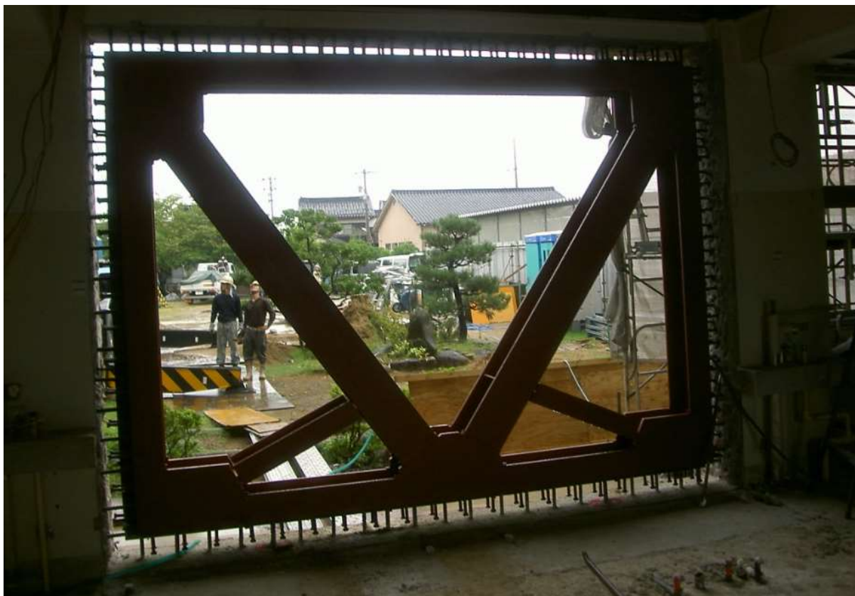
耐震ブレース
