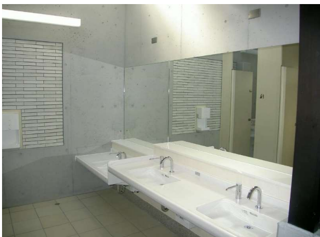
カウンター式洗面器設置
