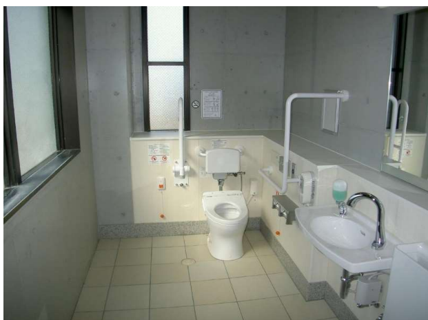
多目的トイレ新設
