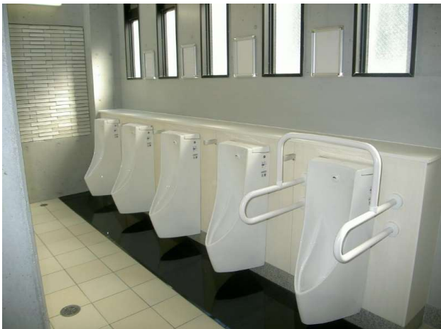
男子小便器手すり設置
