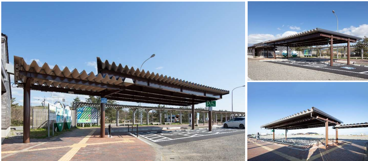
↑高松SA上り線：道の駅高松 里山館 車いす使用者用駐車場
