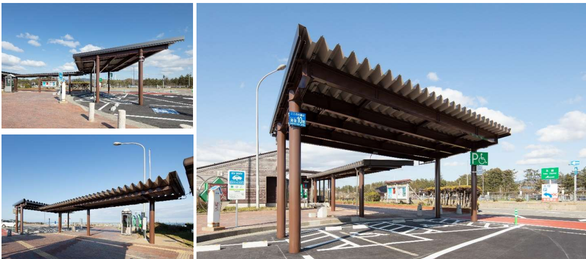
↓高松SA下り線：道の駅高松 里海館 車いす使用者用駐車場
